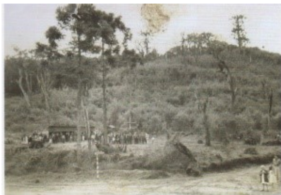
Assentamento inicial para a marcação do local da construção da igreja (sem data)
